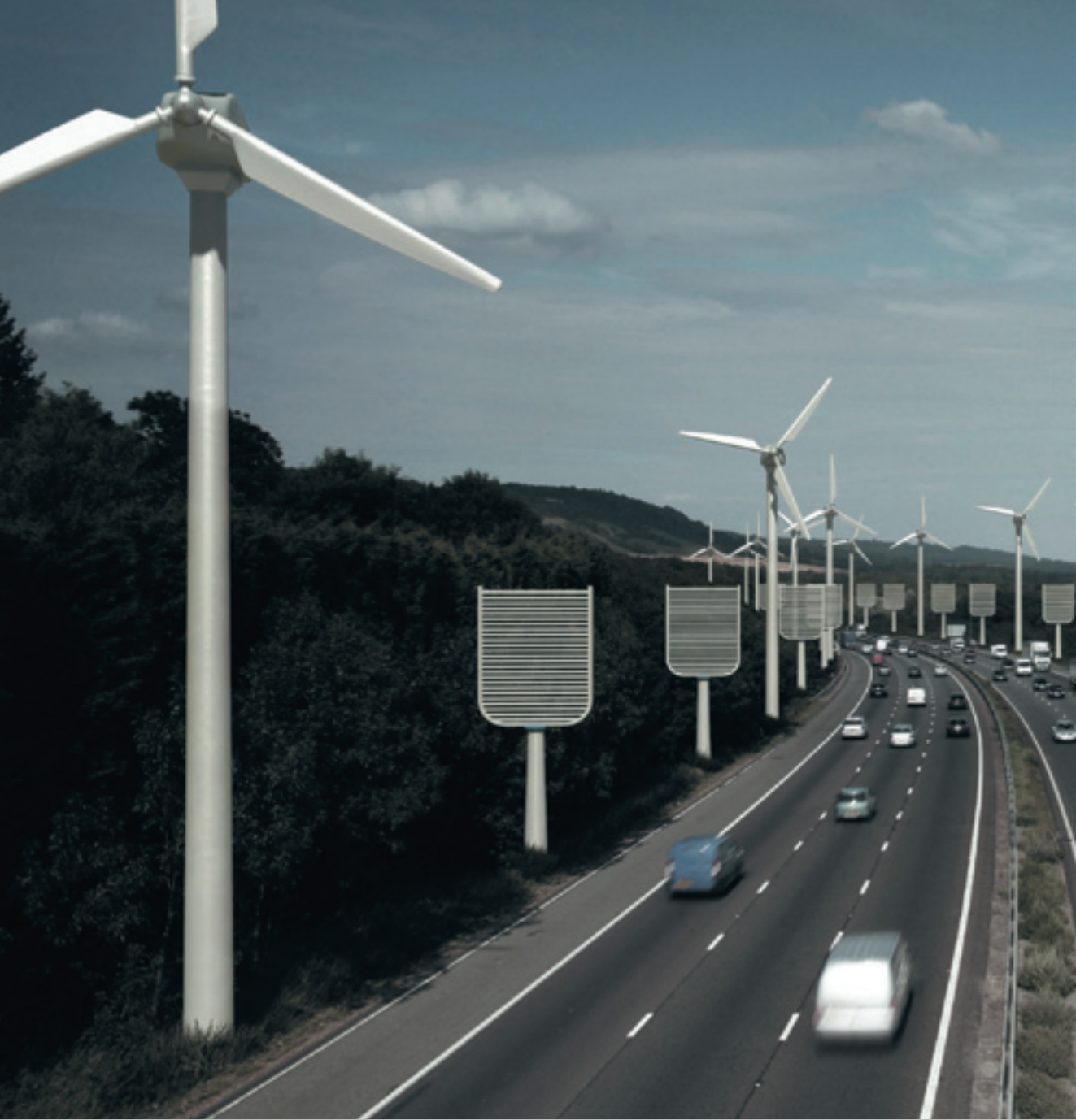
Künstliche Bäume am Rand der Autobahn: Sie würden CO 2 aus der Luft filtern, während Windräder die dazu benötigte Energie liefern
